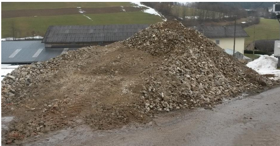
ca. 150 m 3 mineralischer Bauschutt nach dem Abbruch
